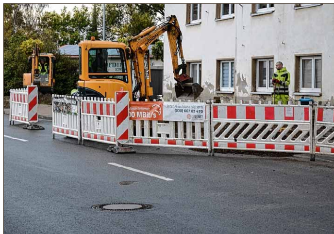
Die Bautrupps mit Arbeitern aus Litauen sind wegen Corona aus der Westlichen Börde abgezogen wurden. Fotos (2): Mathias Müller
