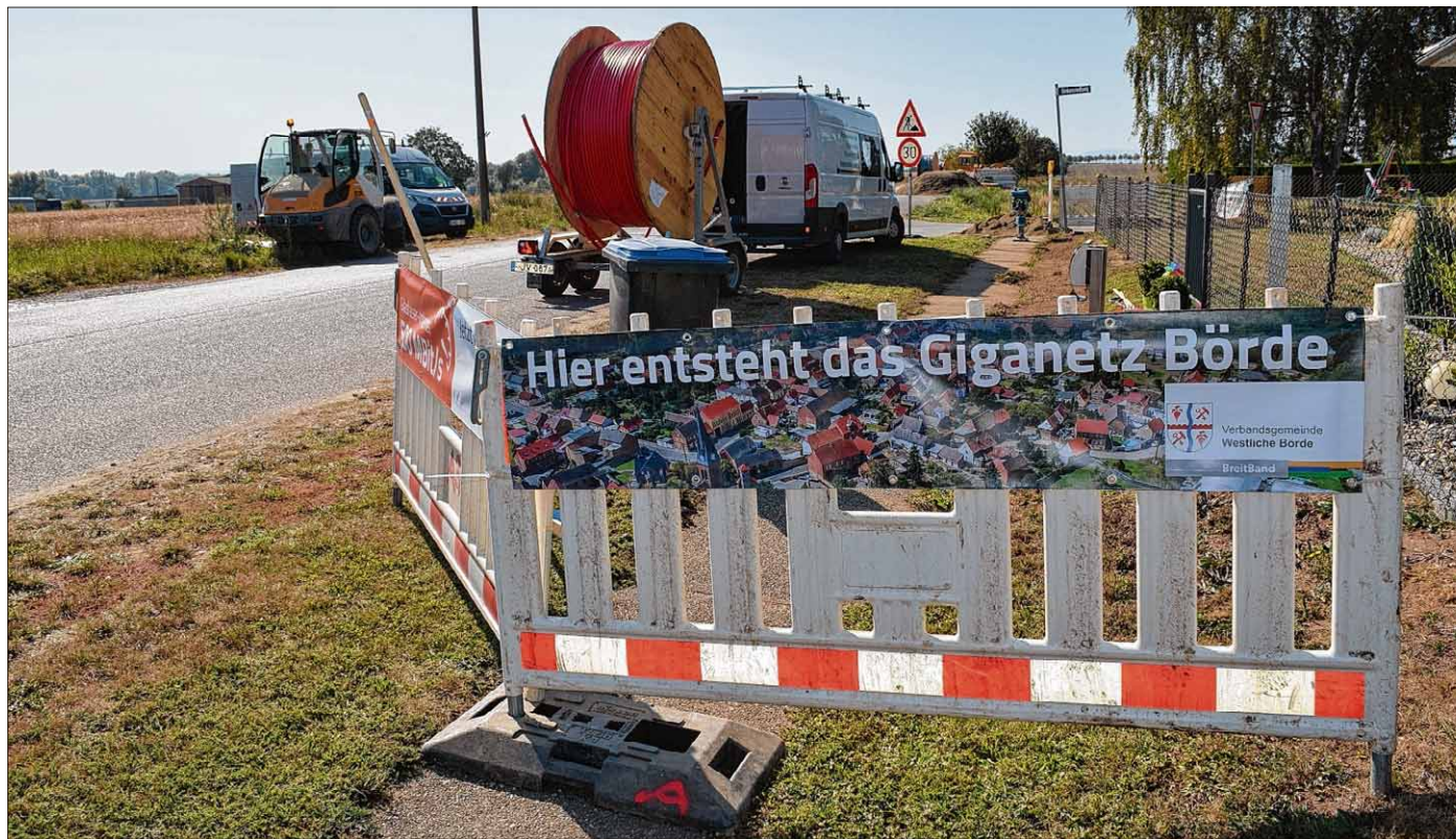
In Kloster Gröningen hatte in der Verbandsgemeinde Westlich Börde Ende September der Bau des Breitbandnetzes begonnen.
