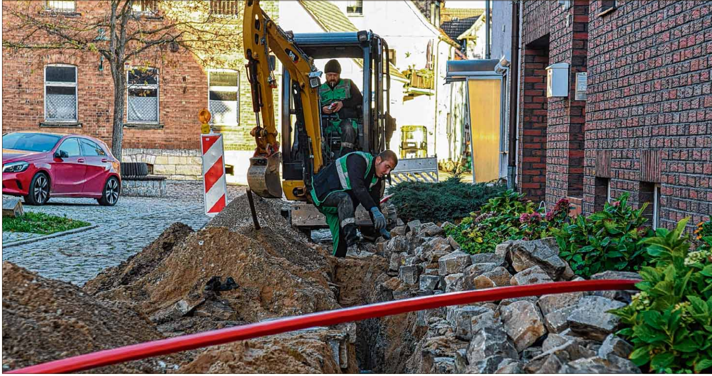
In Hadmersleben werden aktuell Leerrohre für das Glasfasernetz verlegt.
